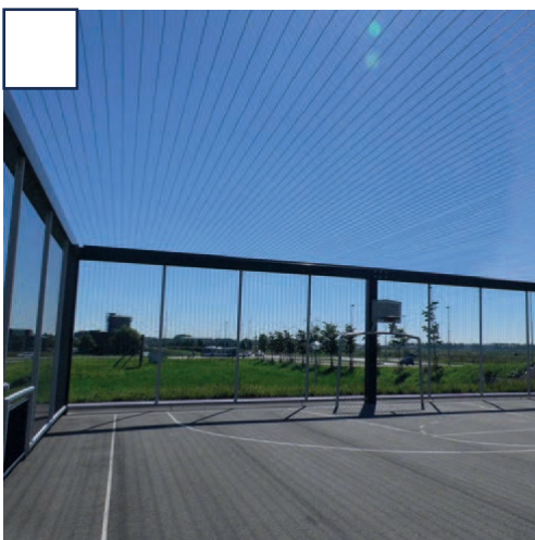
Toit composé de câbles
