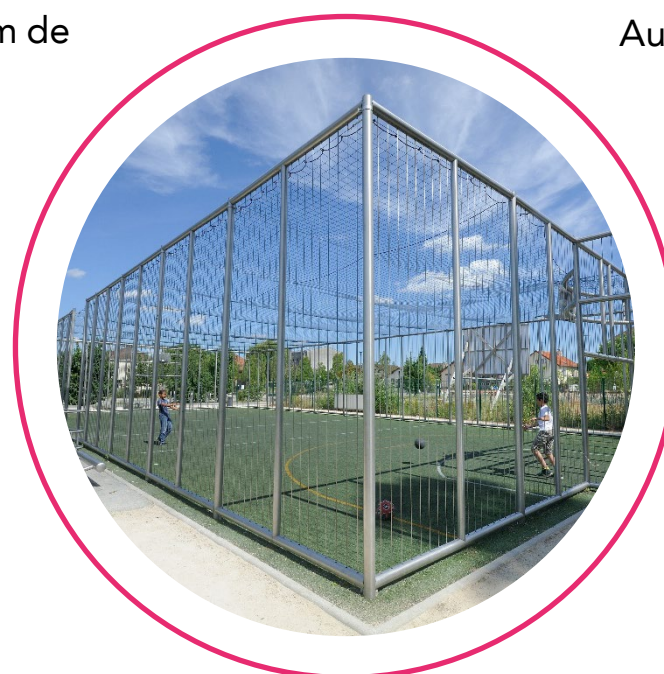
Cette solution de filet tendu n'est plus proposée par IJSLANDER car ne répond pas aux exigences normatives car risque de suspension.
