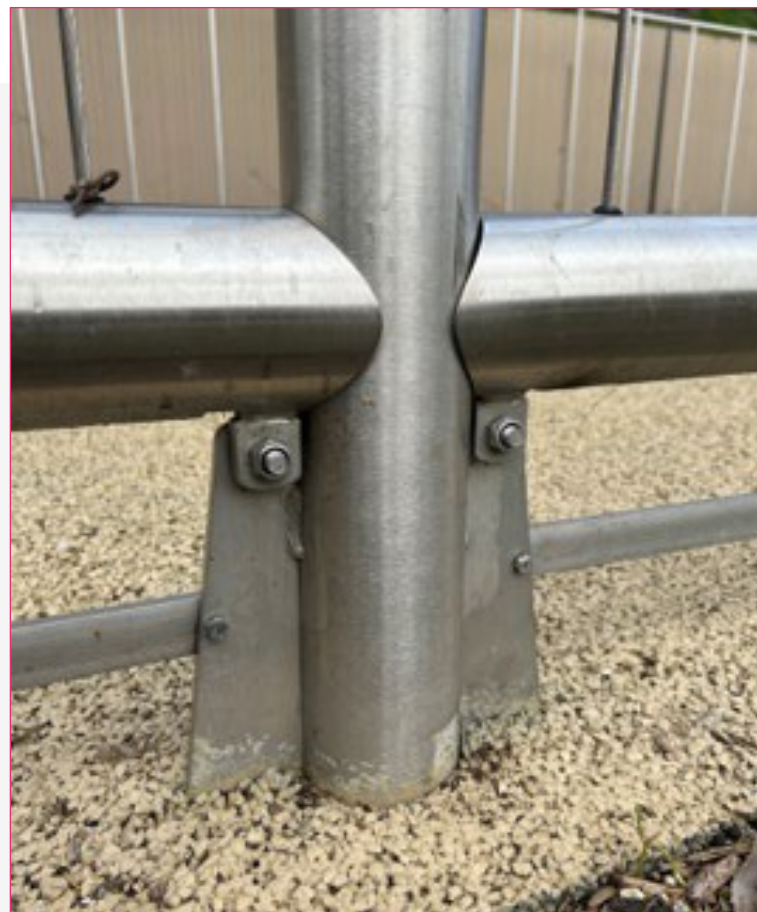
Goussets de renfort sur les points de fixations
