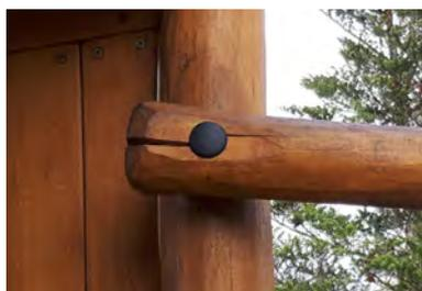
Vissage dans la zone de la fissure : remplacement
